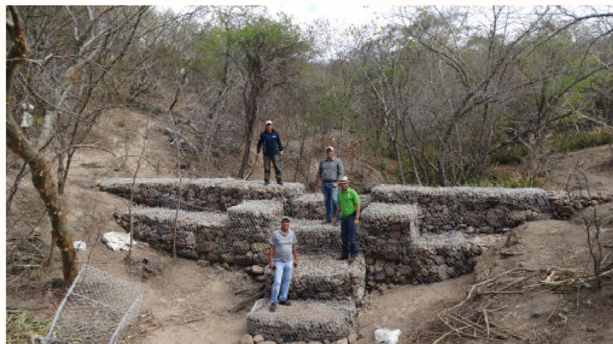
**PRESA DE GAVIONES EN TEMPORADA DE SECAS, RETENCIÓN DE SEDIMENTO Y RECARGA DE ACUÍFERO**
