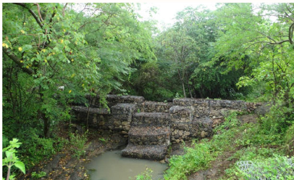
**PRESA DE GAVIONES EN TEMPORADA DE LLUVIAS, RETENCIÓN DE SEDIMENTO Y RECARGA DE ACUÍFERO**
